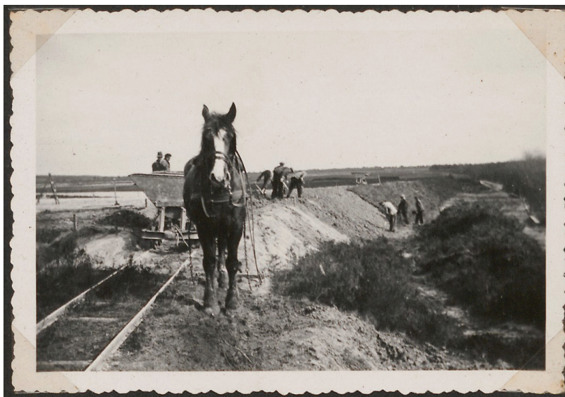
Afb. 2. Aanleg van de waterkerende dam in de Tonnetjesdelle, met behulp van een speciaal aangelegd smalspoorlijntje (Utrechts Archief 1339, 971).
